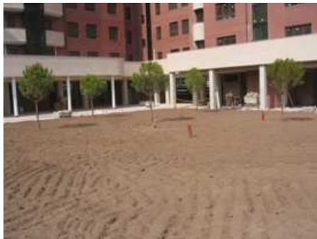
Fig. 11. Zona donde está instalada la sonda de humedad HS2
